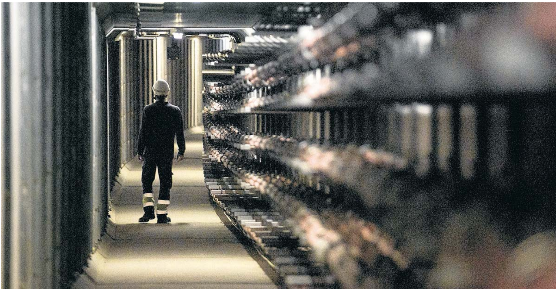
Un operari en un tram dels 41 km de túnels que hi ha, formats per peces prefabricades de 24 tones, de formigó armat i de 20 cm de gruix de paret. CRISTINA CALDERER
