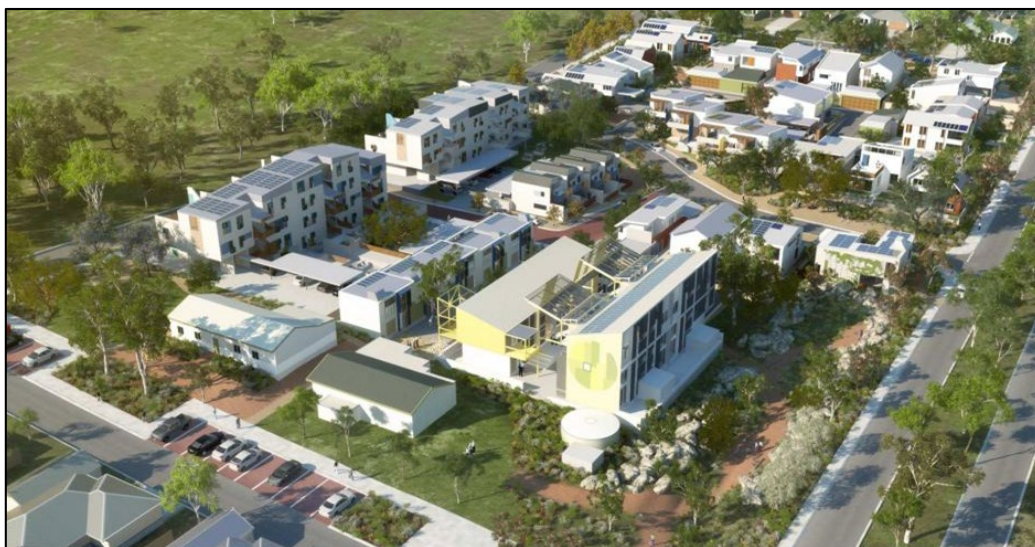
Figura 11. Fotografia de la urbanització de White Gum Valley (WGV). Font: https://www.abc.net.au/news/2016-04-13/solar-home-precinct-launched-in-white-gum-valley/7321468
